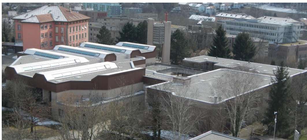
Abbildung 4: Zentrums-Bild 2016, noch ohne PV Anlage auf dem Amts- und Unterrichtstrakt (AUT)
